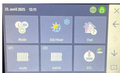
Tableau de commande électronique pour les différents réglages de température et les programmations journalières par plage horaires et par étage
